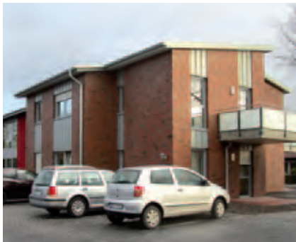
Barrierefreien Wohnkomfort bietet der Neubau „An der Försterei“.
